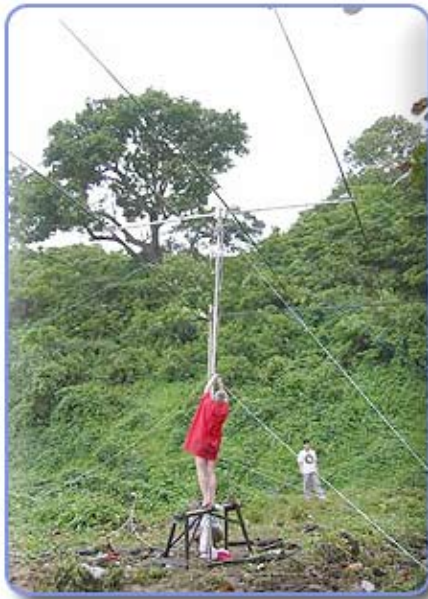
Setup of 3 ele SteppIR Yagi
