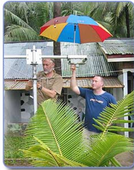
Setup of 3 ele SteppIR Yagi
